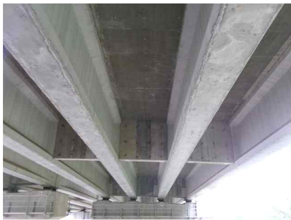
거더 및 바닥판하면 전경
